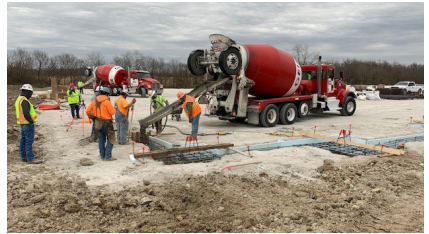
FIRST FOOTING POUR
